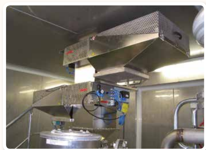
Samočistící cleanflow magnet ve velkém chemickém provozu.
