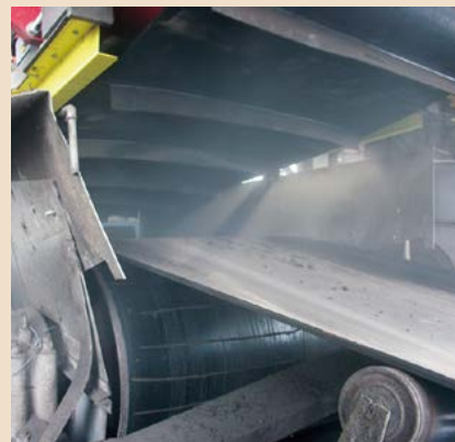
Detail pásu separátoru – elektrárna Kosovo A
